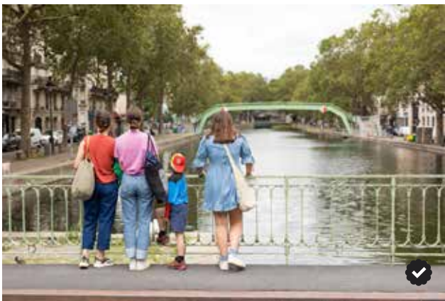
GARDE-CORPS DU CANAL ST MARTIN - 10°
