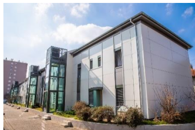
Résidence les Résédas – Grand Prix Rénovation ©GCC AURECA!
