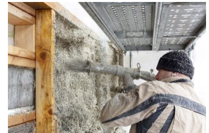
Construction de 15 logements collectifs sociaux en béton de chanvre – Prix de la Presse Bâtiment ©Cécile SEPTET
